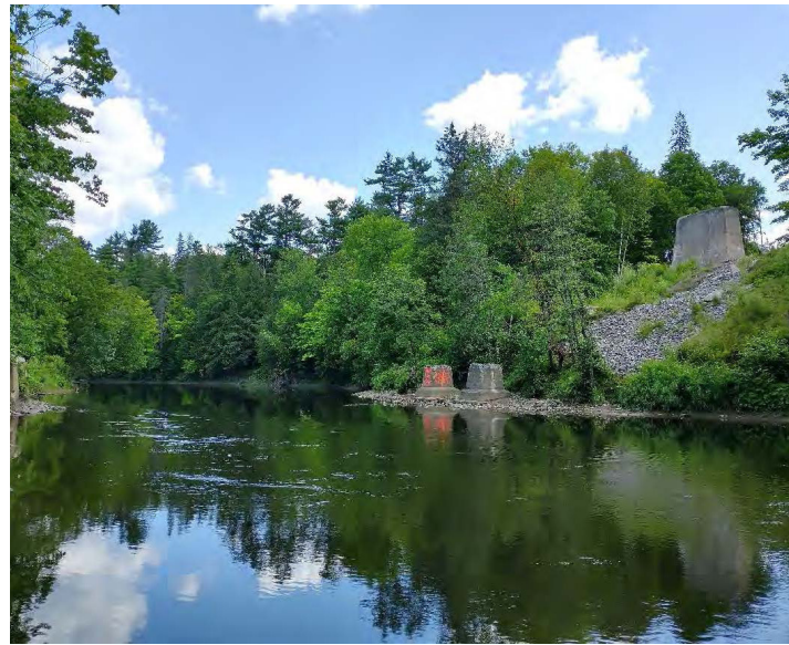
Figure 2.5 Extrémité Nord du Parc régional de la Rivière-du-Nord, vue des ruines du pont ferroviaire du Canadien National, Prévost) Source : WSP (2021)
