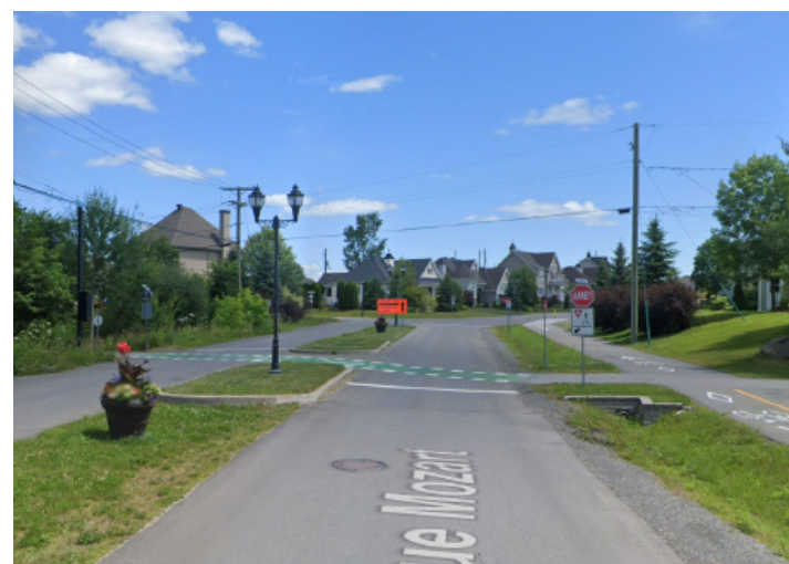
Figure 2.37 Rue locale ayant la forme et le rôle d'une collectrice (rue Mozart, intersection du Parc Linéaire le P'tit Train du Nord, Prévost) Source : Google Streetview (2023)
