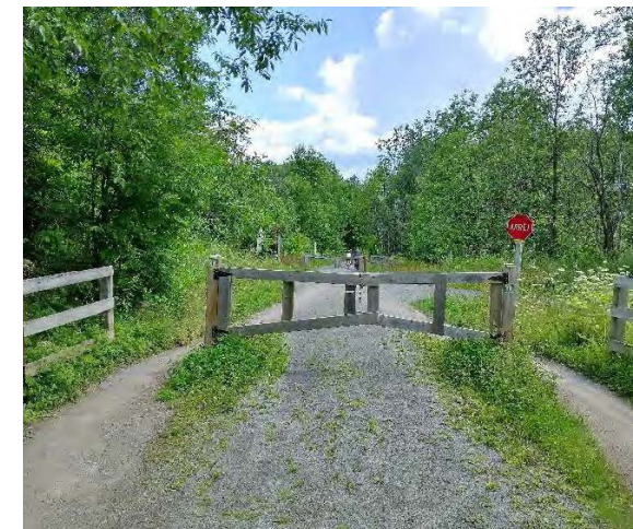
Figure 2.26 Chicane avec arrêt en retrait de la chaussée (Le Cheminot, Prévost)
