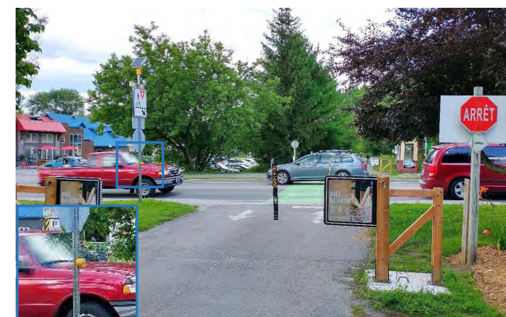
Figure 2.28 Positionnement inadéquat du panneau d'arrêt et du bouton-poussoir
