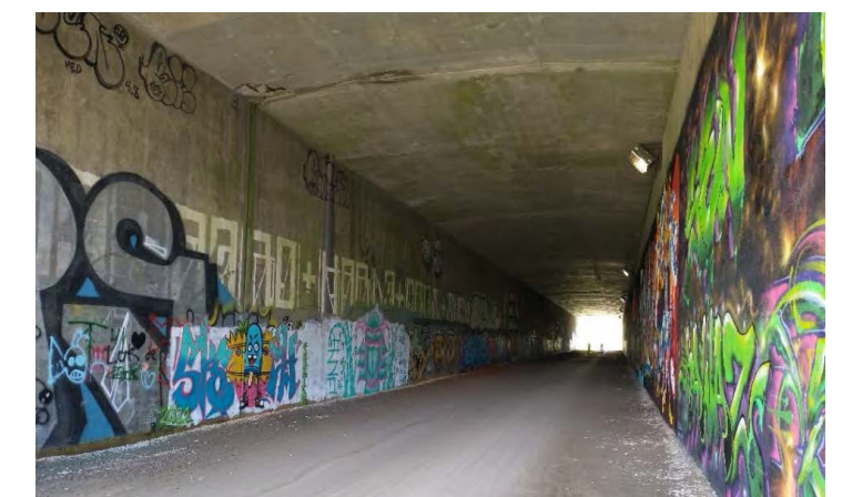
Figure 2.30 Éclairage du tunnel sous la R-117
