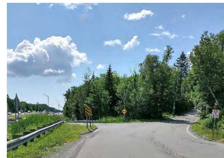
Figure 2.40 Carrefour atypique (montée Sainte-Thérèse, intersection rue de la Falaise et bretelle d'accès vers l'A-15 en direction sud, Prévost) Source : WSP (2021)
