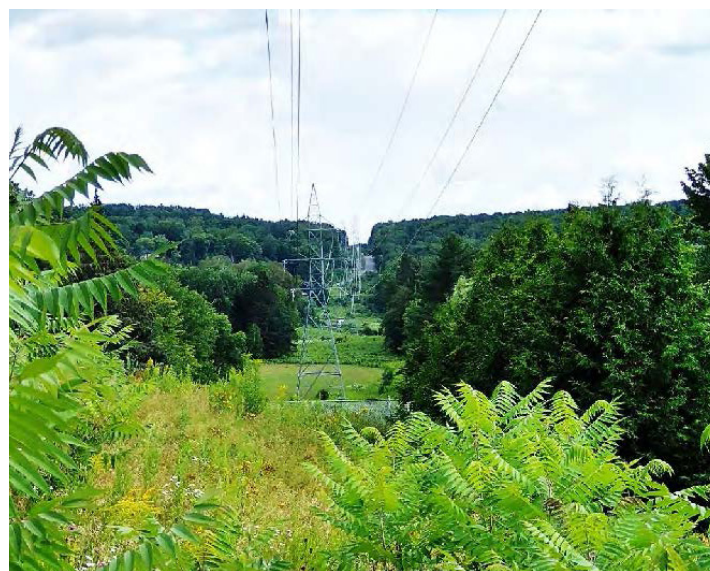
Figure 3.4 Lignes à haute tension d'Hydro-Québec Source : WSP (2021)
